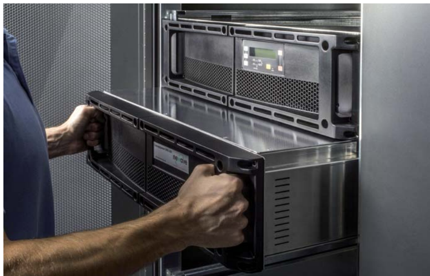
Rys. 3. Wymiana modułu EcoPower DPA Plus
